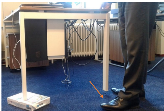
Foto 1: Scheefstand in een werkkamer van het nieuwe pand
